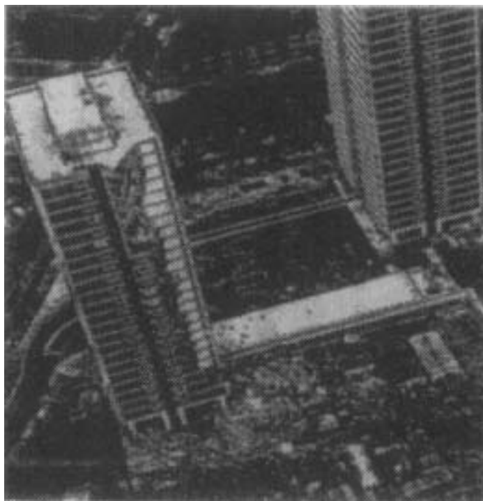
写真1 連鎖反応で22階分が一瞬のうち崩壊 [1]
