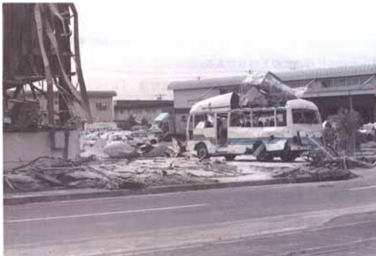
図3 被害の状況(その2)
