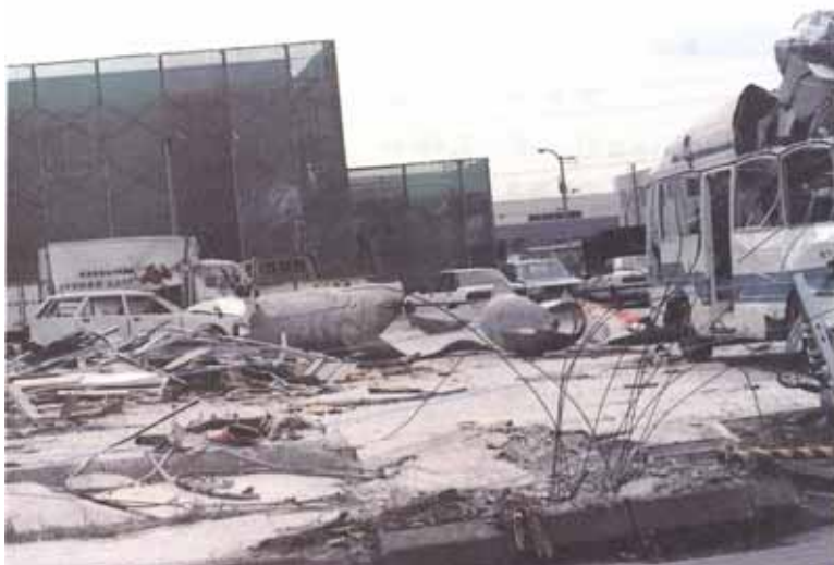
図4 被害の状況(その3)
