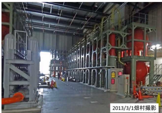
図7 駆動源となる油圧アキュムレータ
