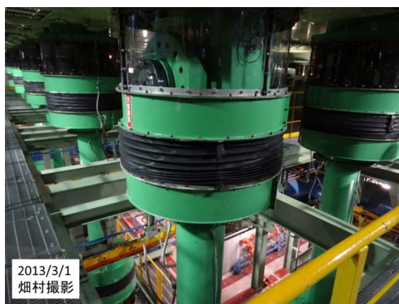
図5 Z方向の3次元継手
