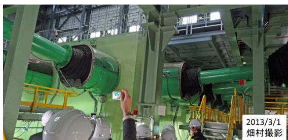
図4 XY方向の3次元継手
