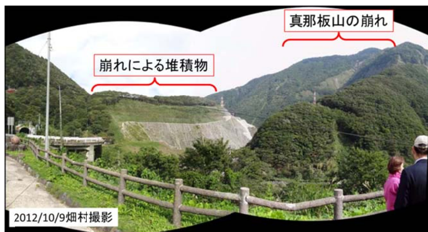
図5 國界橋から真那板(まないた)山の崩れを見る
