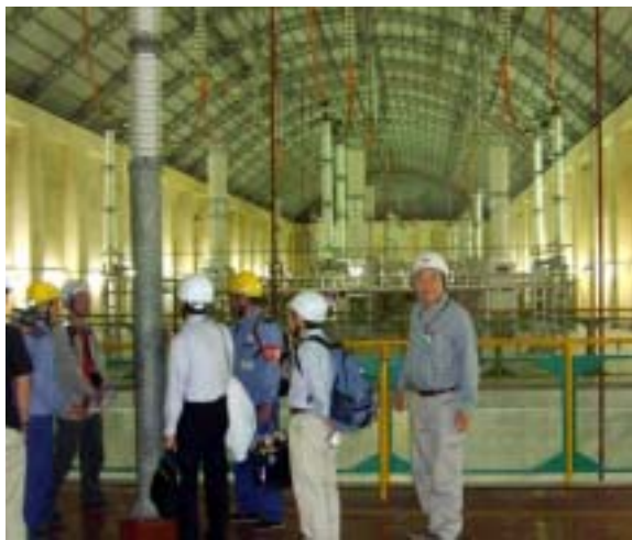
写真5 黒部第四発電所の開閉器室 (2006/8/7撮影)
