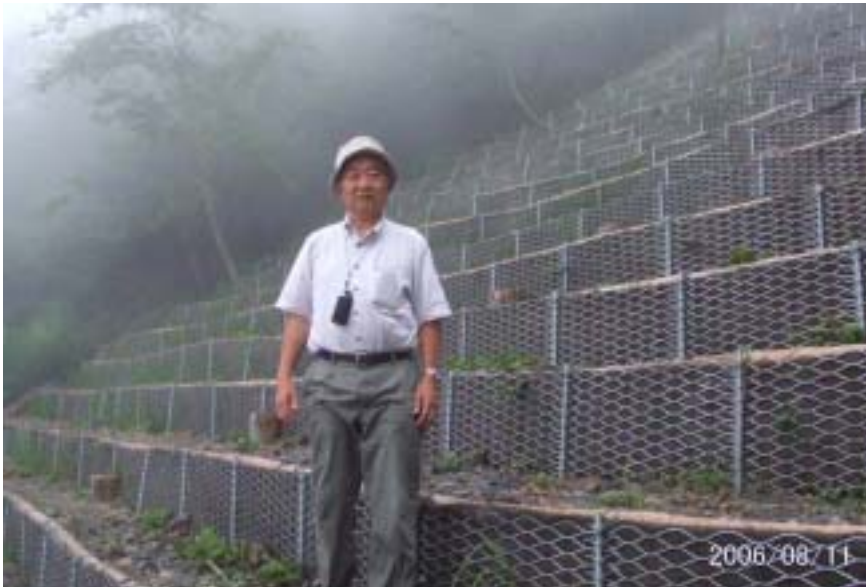
写真21 大谷崩の山腹工に立つ筆者
