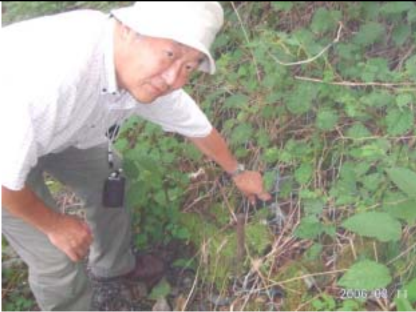
写真24 大谷崩の山腹工。 植物を根付かせるため小石の表面に金網が張り付けてある
