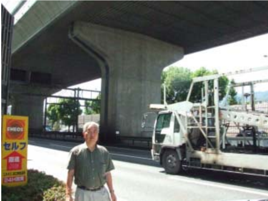
写真25 イチョウの形の太い橋脚で建て直された阪神高速道路 27
