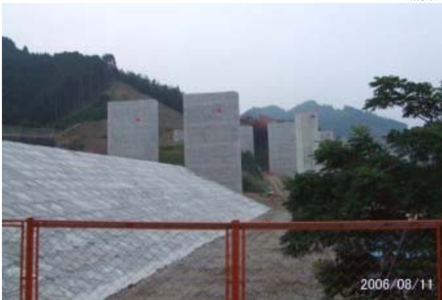
写真13 工事中断中(?)の第2東名高速道路(静岡駅近くで)
