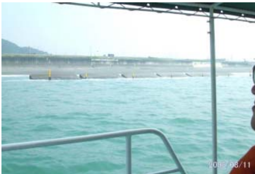
写真6 有脚離岸堤による波浪による海岸侵食防護
