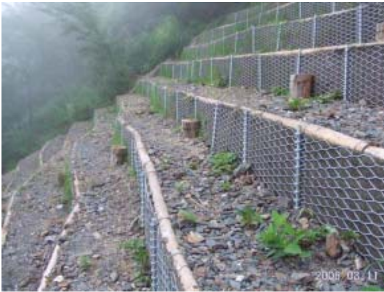
写真20 大谷崩の山腹工 長さ1.5mの上部0.5mだけが表に出て網板を支え、 その後に小石がつめてある。
