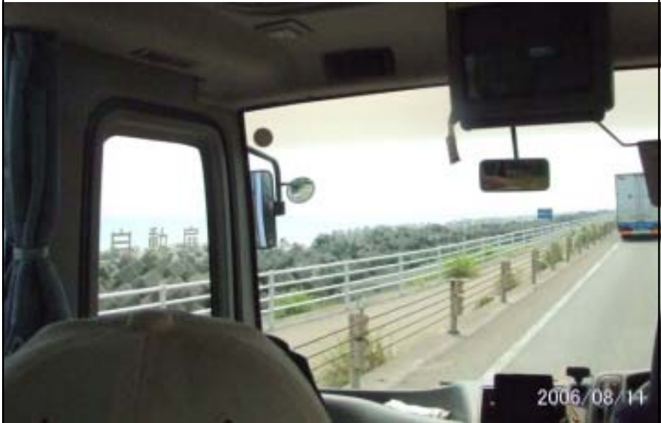
写真4 久能海岸の護岸用テトラポット群を道路側から見る
