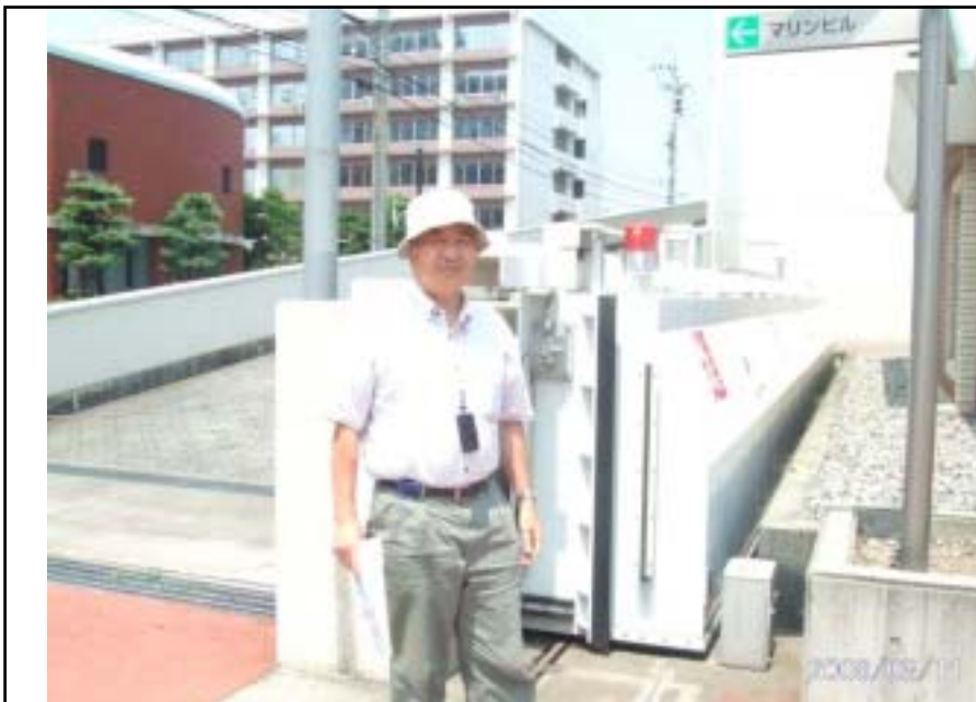
写真9 津波防護のための遠隔操作扉
