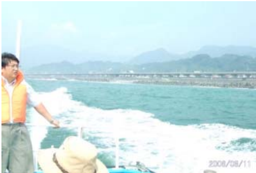
写真5 テトラポットによる海岸侵食防護
