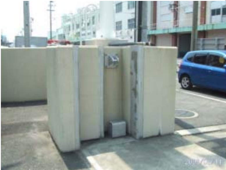
写真11 津波防護用可動扉の受けの部分。 (生存空間の考えがないので人が挟まる可能性がある)
