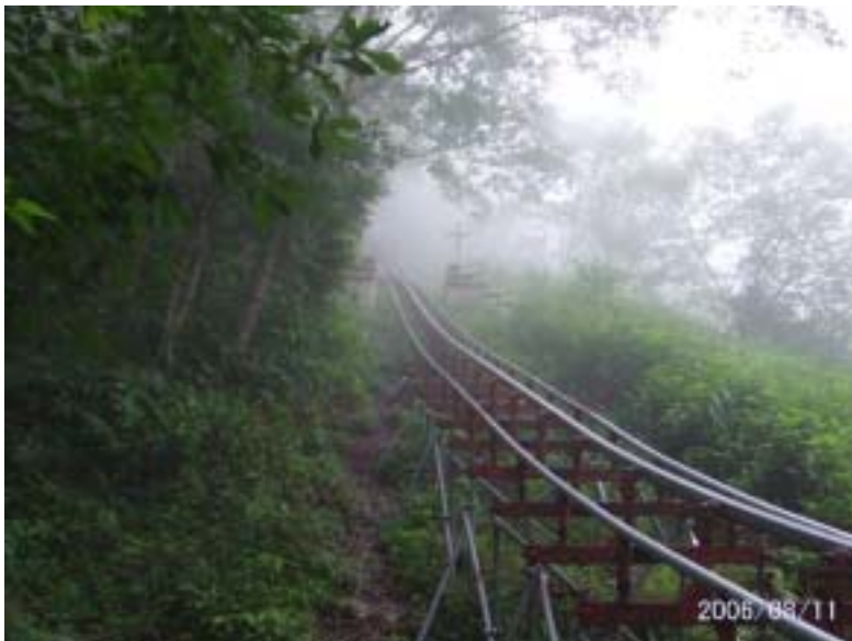
写真19 大谷崩山腹工工事の人員・資材運搬用モノレールの軌道 (中央のレールにツメ車がかみ込むらしい)
