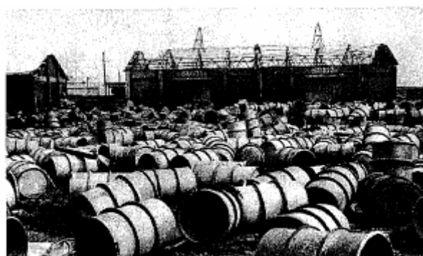
野積み硝化綿は約2,000本。正面が出火場所に推定された。
