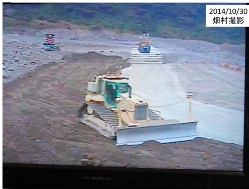
図19 オペレーションルームでは土砂を型枠にを使った コンクリート製堰堤の構築の動画が表示されていた。
