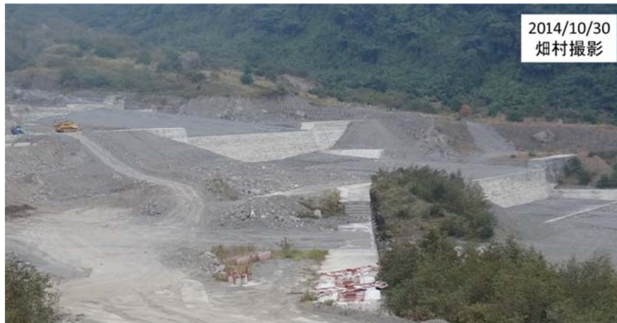
図17 無人化施工で作られる砂防堰堤の工事現場全景
