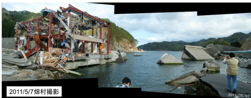
図32 両石湾奥の崩れた防潮堤 ～高さ12mの防潮堤がめちゃくちゃに倒れていた～
