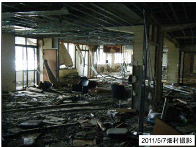
図24 津波に洗われた大槌漁協2階内部
