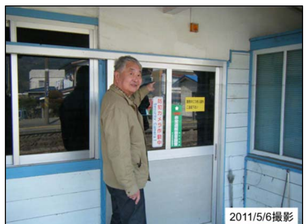
図6 津軽石駅の駅舎に残る津波の痕跡
