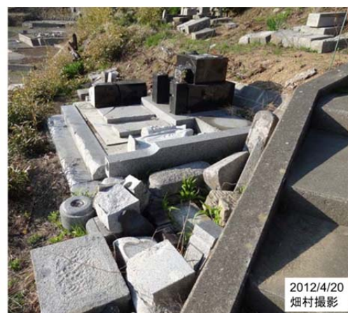
図6 津波で折れたりもぎ取られたりした墓石 ～津波の水平方向の力の大きさがわかる～
