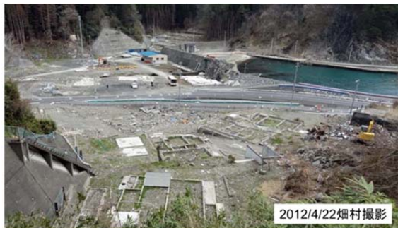
津波に残ったコンクリートの防潮堤と建物の土台だけが見える。
