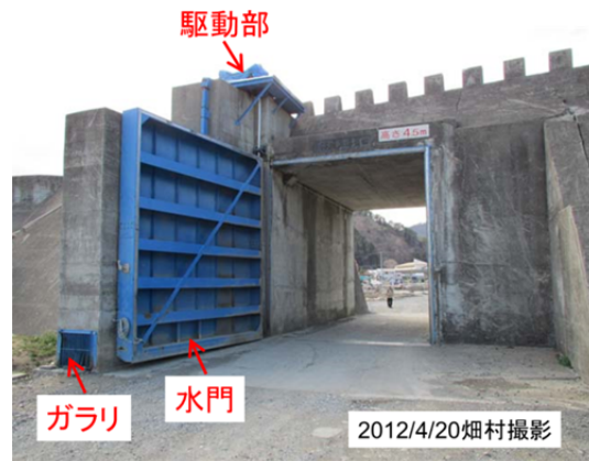
水門は開かれ、何かで固定されていた。 図23 田老の防潮堤X字交点にある水門
