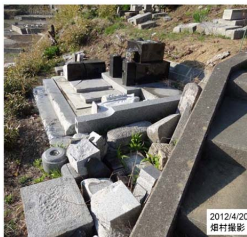
図6 津波で折れたりもぎ取られたりした墓石 ~津波の水平方向の力の大きさがわかる~
