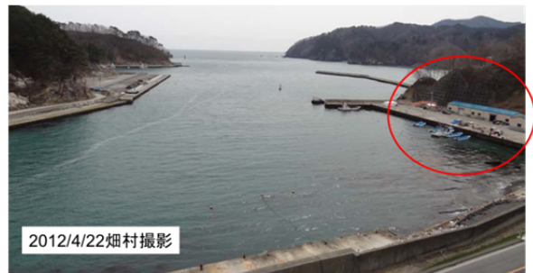
湾の右手には漁業用の小屋が建てられ、小船が係留され、漁業が再開していることが見てとれた。
