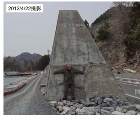
図9 両石の津波の破壊に残った防潮堤と畑村
