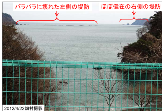
20年の歳月と1200億円をかけて作った世界最大の水中堤防も今回の津波であっけなく壊れた。
