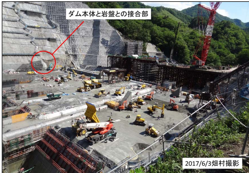
図5 下から見た工事中のハツ場ダム
