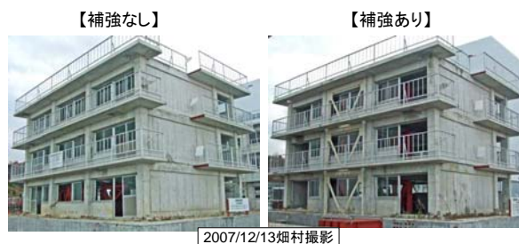
写真13 実物大の学校建物の補強の効果
